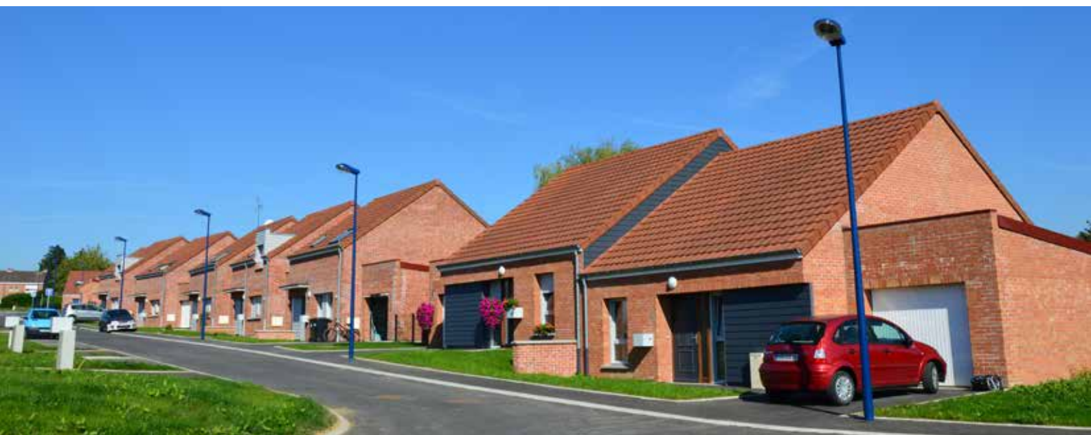
JEUMONT - Résidence JUMETIAU, 20 logements collectifs, 12 logements en accession, 22 parcelles viabilisées
