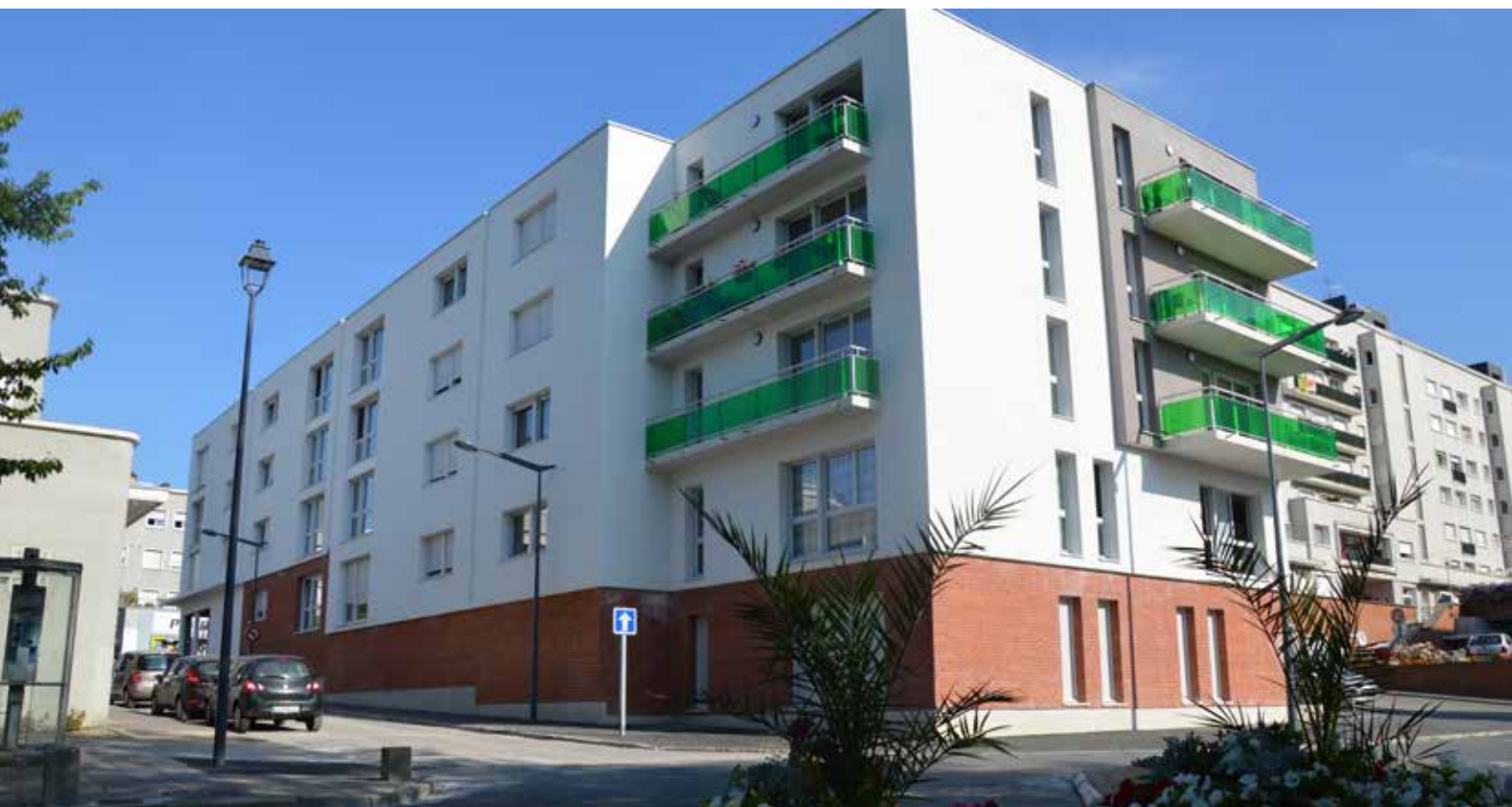
MAUBEUGE - Résidence JAN GOSSART, 30 logements locatifs
