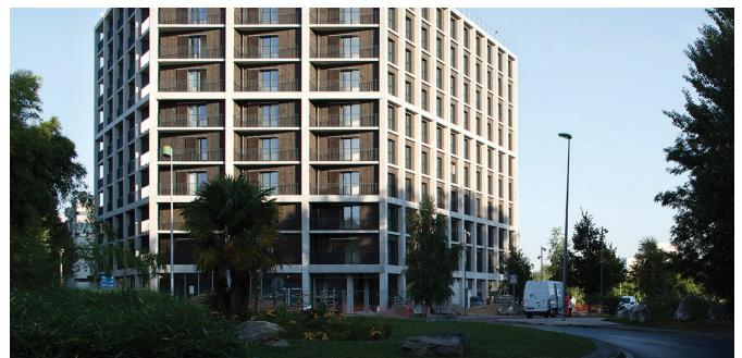
3F Résidences à Champs-sur-Marne : livraison d'une résidence universitaire de 172 logements © VILLEMARD ASSOCIÉS
