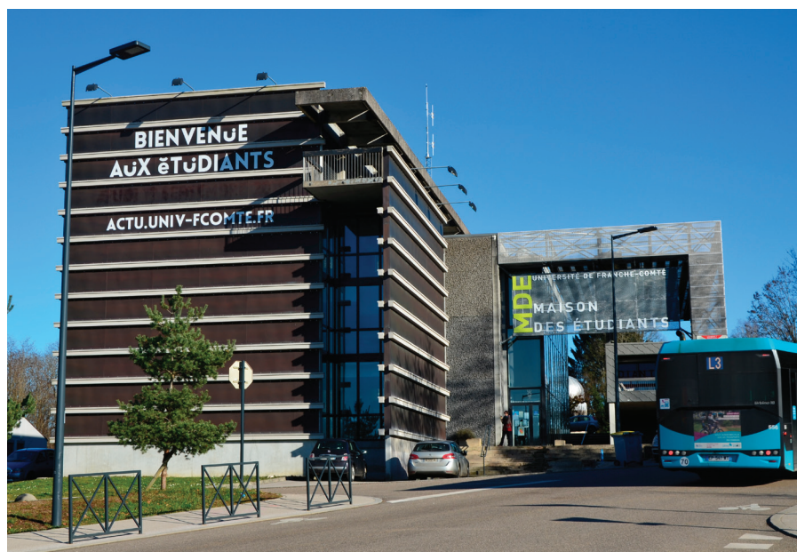
Maison des étudiants, campus de la Bouloie, Besançon © AUDAB
