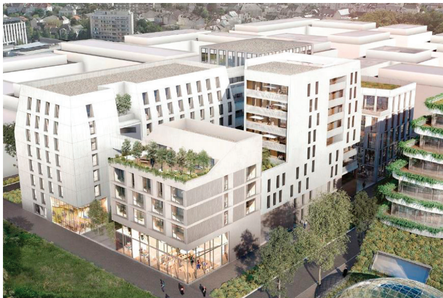
Résidence étudiante Cœur de Maine Angers Loire Habitat - Architecte Patriarche © ANGERS LOIRE HABITAT
